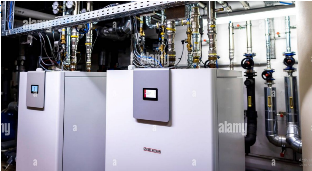
Stiebel eltron HP kaskadinės sistemos pavyzdys
