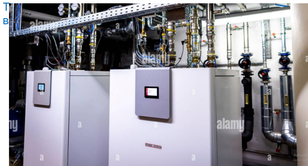
Пример за каскадна система с термопомпи Stiebel Eltron
