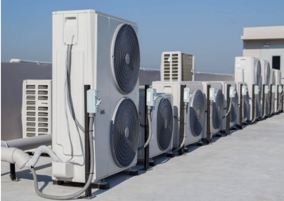
Пример за каскадни термопомпени системи
