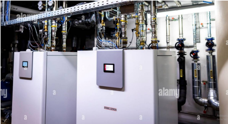
Ejemplo de un sistema en cascada de bombas de calor Stiebel Eltron
