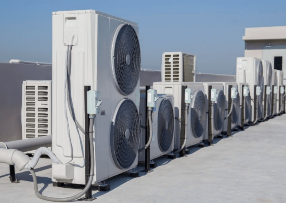
Ejemplo de un sistema de bombas de calor en cascada
