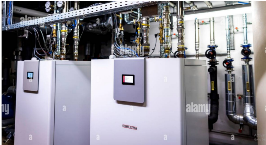
Exemple de système en cascade de pompes à chaleur Stiebel Eltron.
