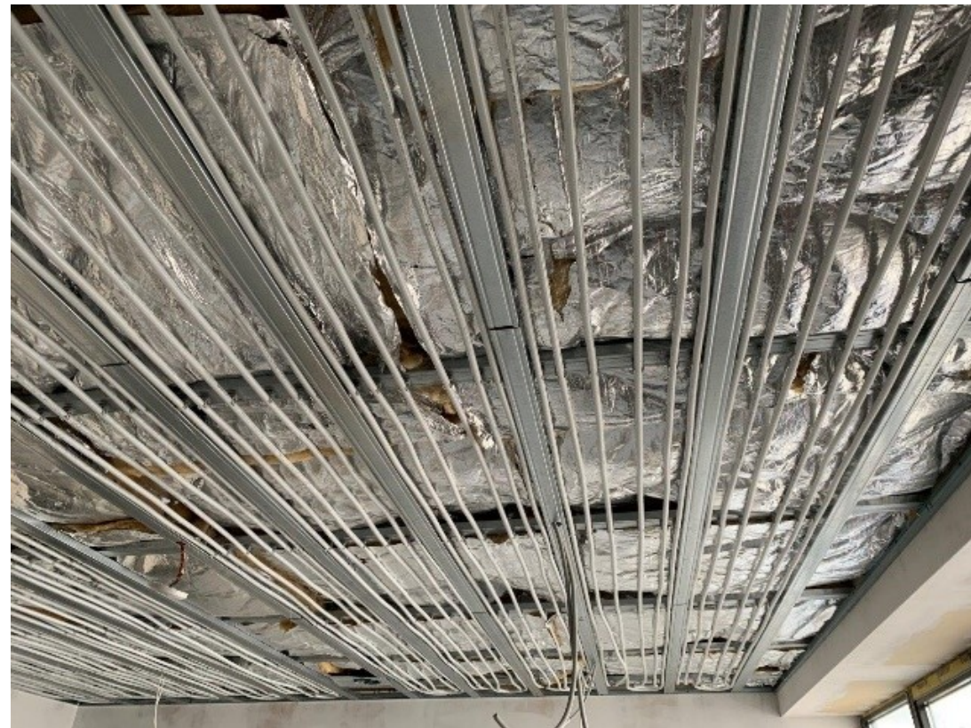
Лъчисто таванно отопление/охлаждане
